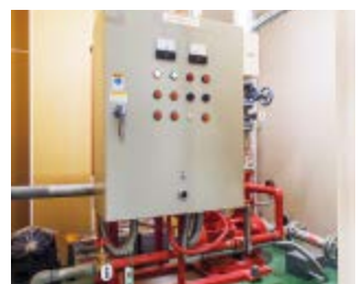
消火ポンプも日立製
